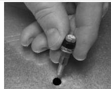
Poser les douilles Plusnut dans les trous percés. Utiliser une nouvelle rondelle en étoile pour chaque douille Plusnut.
